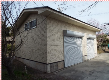
農機具倉庫の建設
