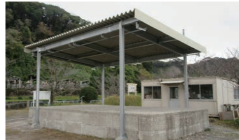
▶ 鉄道記念公園ステージに屋根を設置
