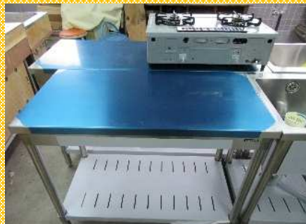
調理室備品整備
