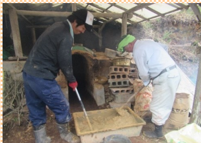
炭焼き窯の改修
