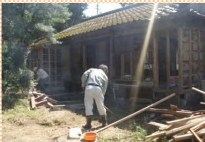
移住者の受入れのための空き家改修
