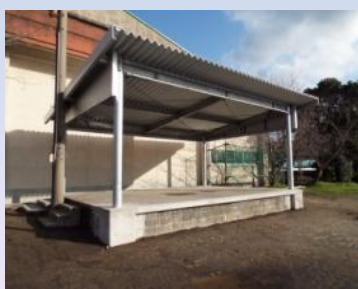
屋外ステージ屋根の建設(H26年度)
