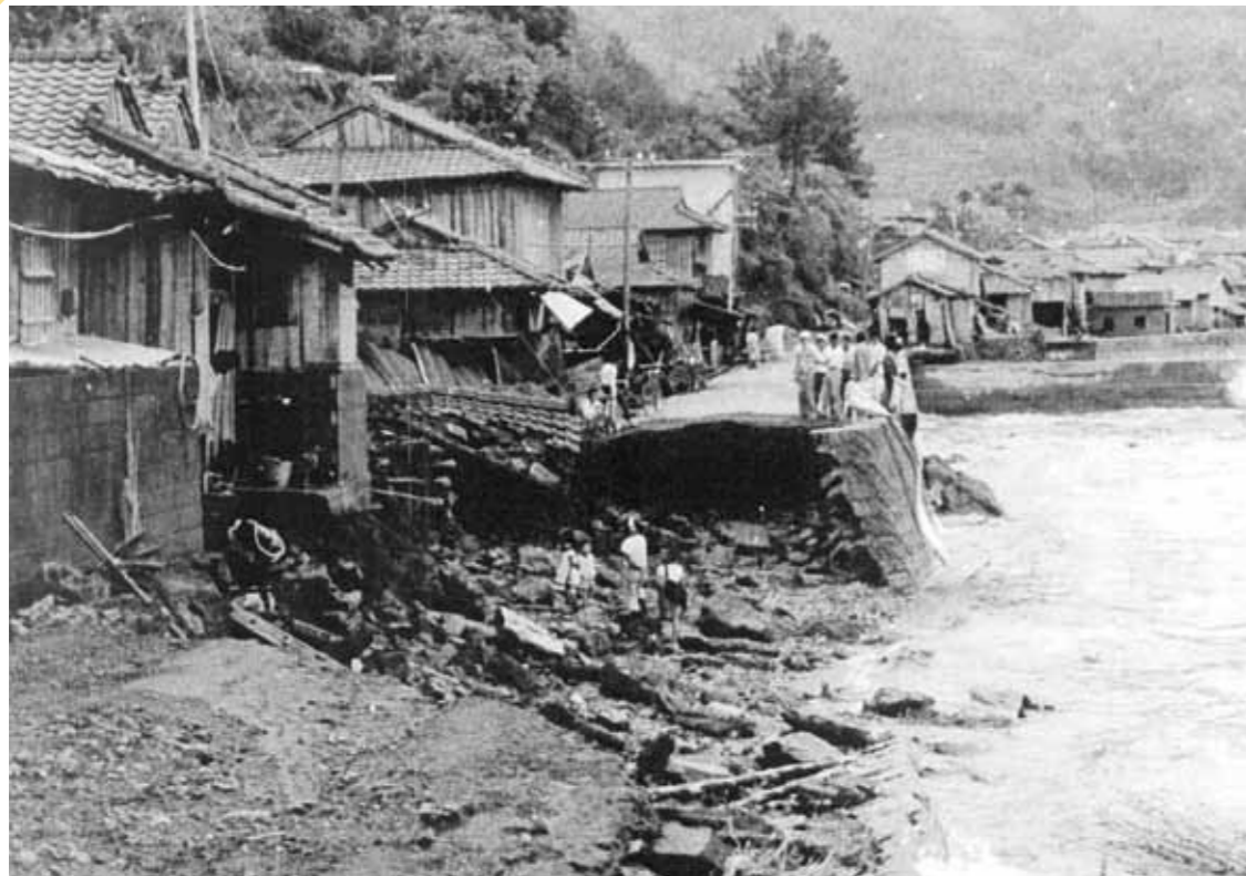
ルース台風被害／昭和26年10月14日に九州に上陸したルース台風による被害
