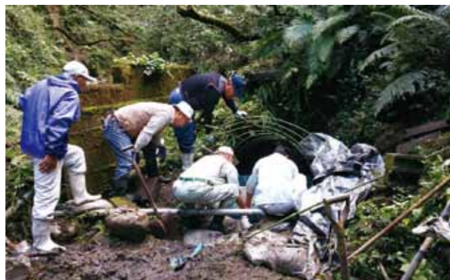
牛根麓簡易水道修繕工事
