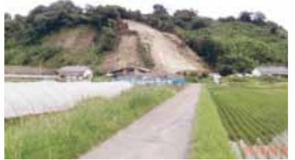
市木馬口地区山崩れと復旧工事の状況
