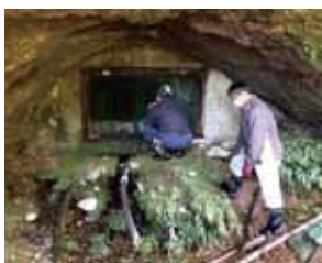
浮津の取水口
