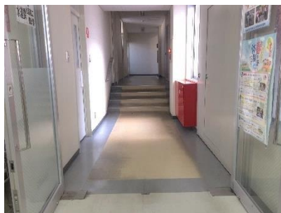
[ 本館と新館の連絡通路にある段差 ]
