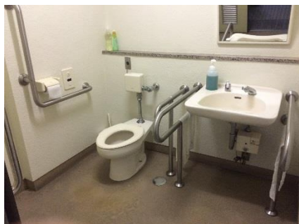
[ 車いす利用者対応ではあるものの、乳幼児連れやオストメイト* 3 対応ではない ]
