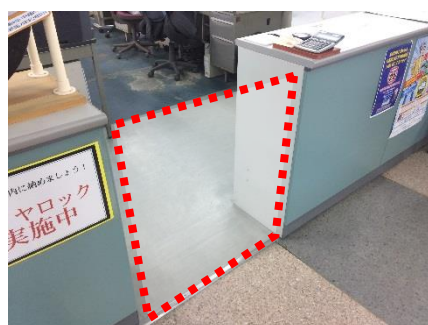
[ 窓口カウンターにあおり戸などがなく、外部進入などの防犯対策上の不安がある ]
