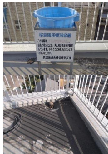
[ 現庁舎の屋上 ]
