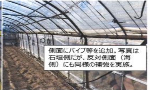
側面の補強（強風対策）
