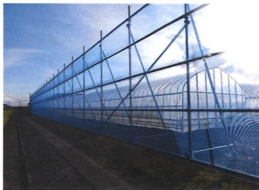
防風ネットの設置
