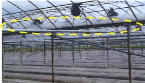
タイバーの設置による補強
