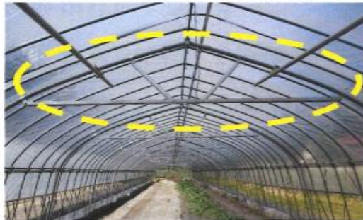
タイバーの設置による補強
