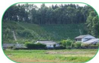
土砂崩れを防ぐ
